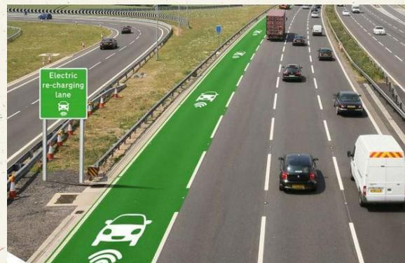
Figura 19: Recarga de vehículos eléctricos sin necesidad de detenerse ni conectarse a la red eléctrica.
